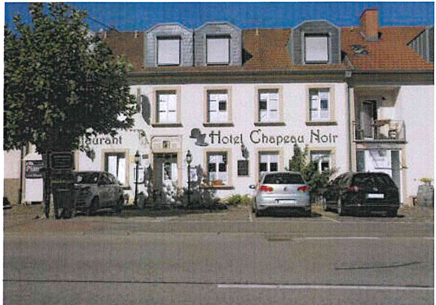
Auf die Fassadengliederung abgestimmt Werbeanlage im Bereich des Hotels „Chapeau Noir“
