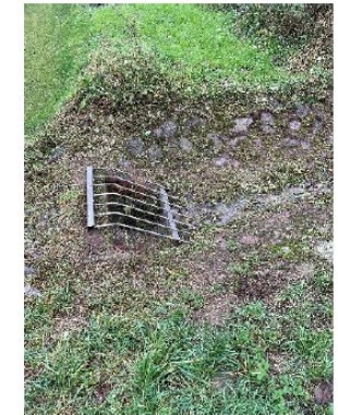
gesäubertes Einlaufbauwerk bei letzten Haus in Straße
