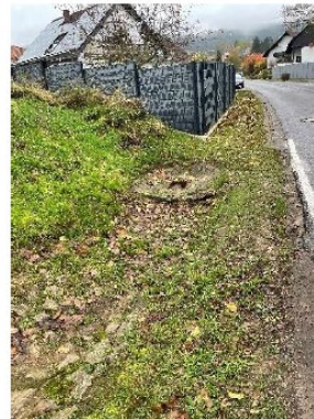
Einlaufbauwerk Altforweilerstraße am Ortsausgang Felsberg Richtung Altforweiler
