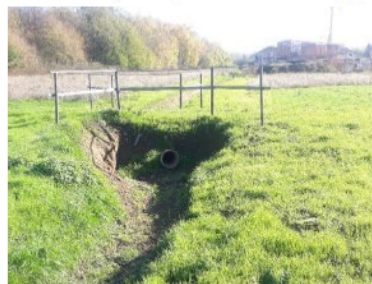
Foto vom 23.11.2024 – Fußwegebrücke oberhalb Neubaubereich
