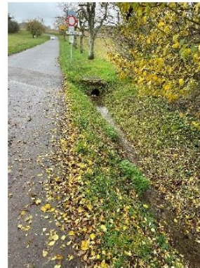
Einlaufbauwerk Straße „Großwies“
