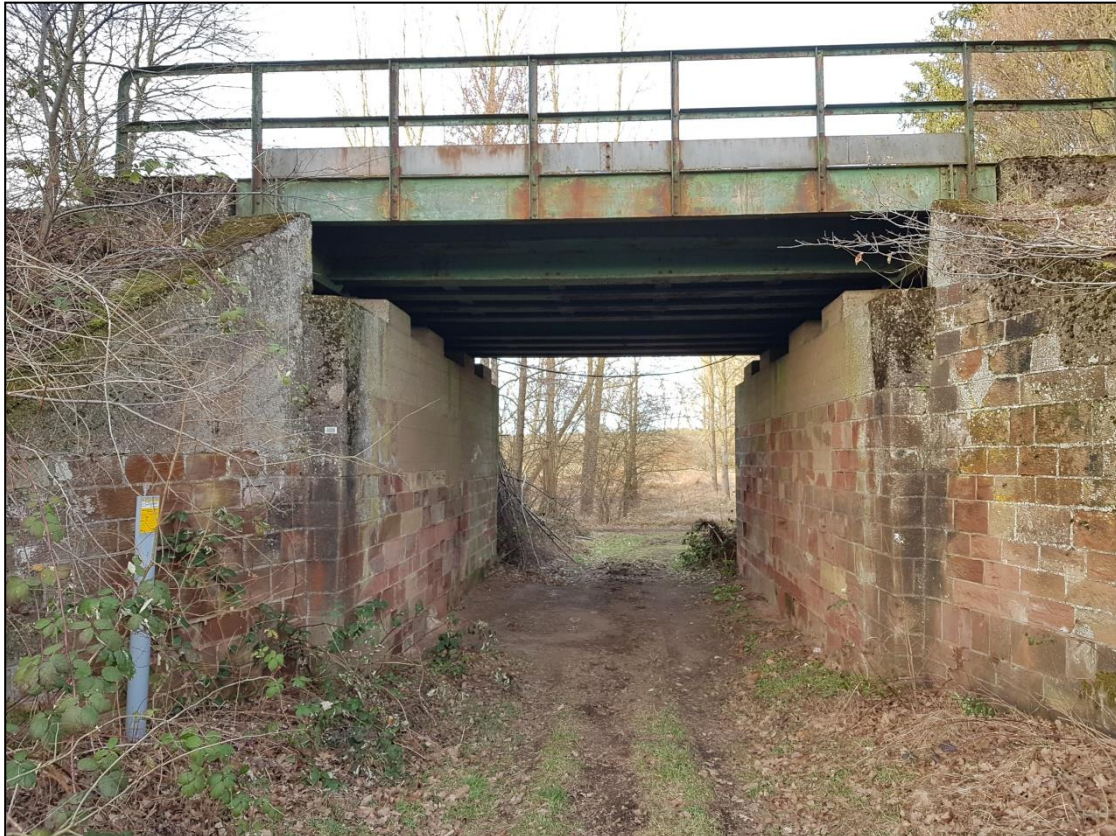
Abb. 5.2-16: Eisenbahnunterführung im Nordostteil des Untersuchungsraumes
