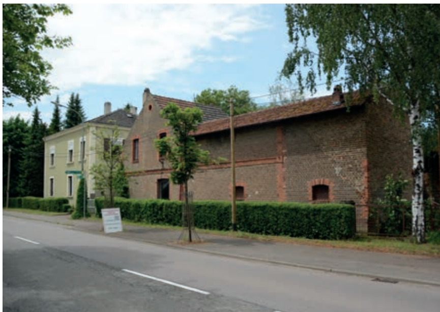
Blick von der Metzger Straße auf das Plangebiet
