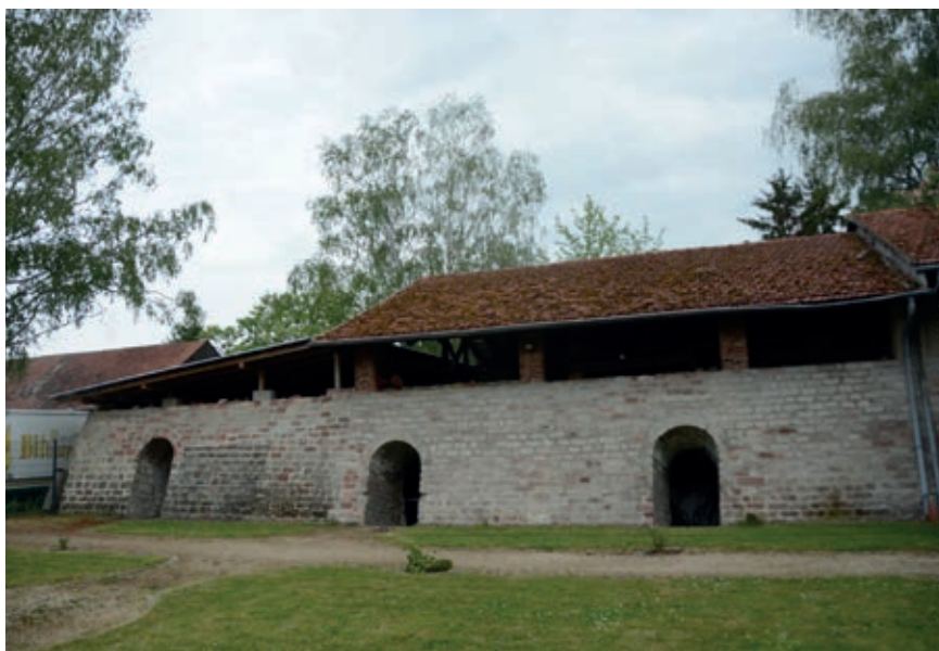
Gebäude des ehemaligen Kalkwerks
